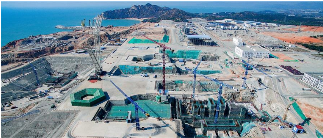
图 3.4.2-6 陆丰核电一期工程建设现状
